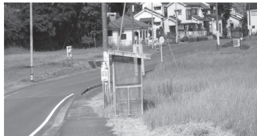
湯之尾地区地盤沈下箇所一部
