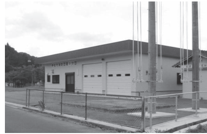
新築された第9分団詰所
