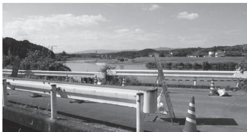
川南～栗野線 白川橋
