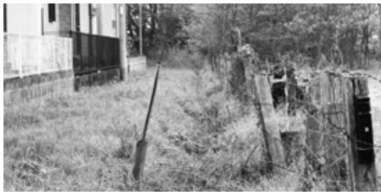
▲土水路の荒廃が浸水被害を招いている
