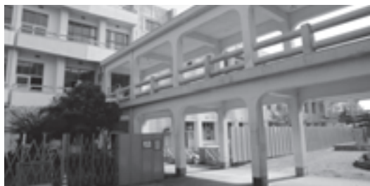
▲改修中の校舎
