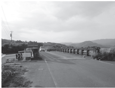
大道下青木線に架かる上目丸橋
