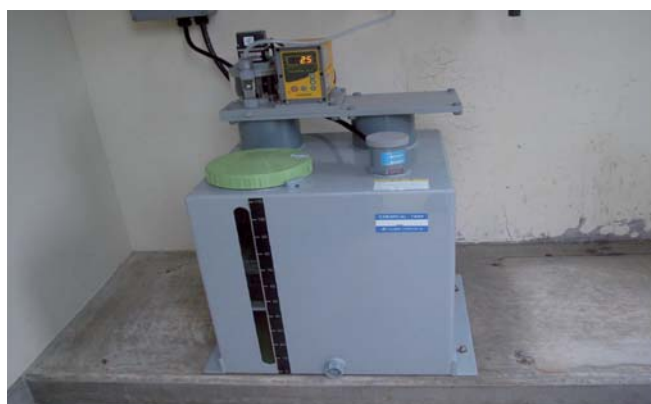
菱刈地区滅菌設備改修(6ヶ所) ※写真は北部地区
