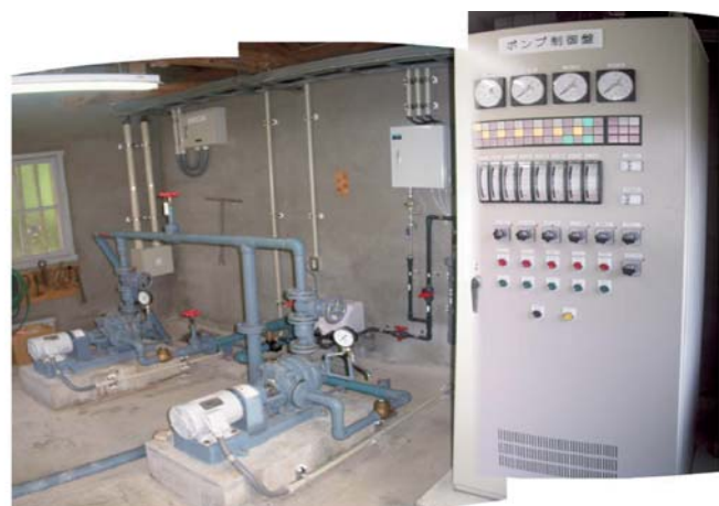
崎山水源地集中監視整備
