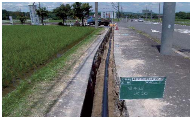
国道267号配水管新設(大口南中)
