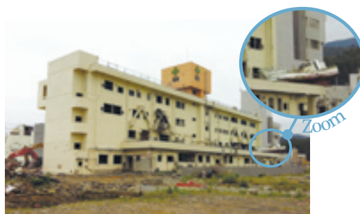
解体される公立志津川病院
