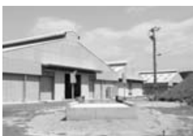
(試験稼動した堆肥センター)
