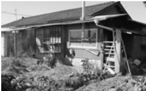
老朽化した市営住宅
