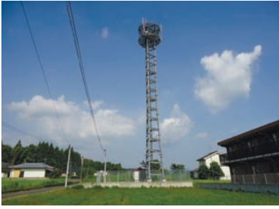
通信施設・電波塔
