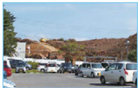
▲急ピッチで進む高台移転の造成現場
