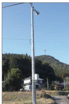
屋外放送設備
