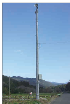
屋外放送設備②
