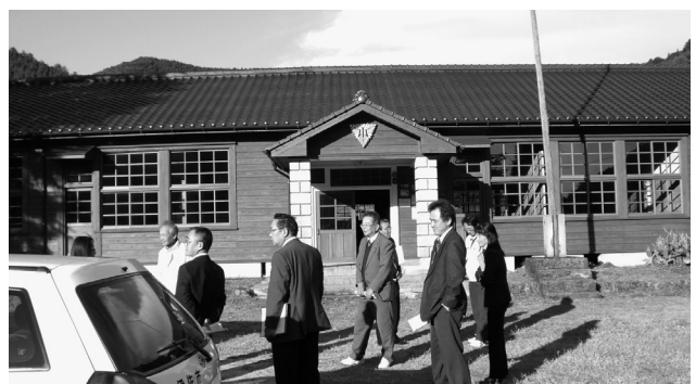
改修工事を終えた旧布計小学校跡
