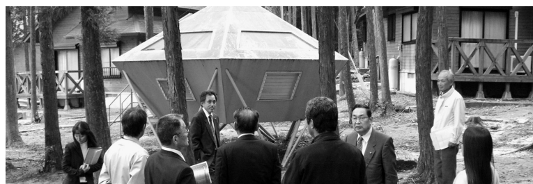
U F O型バンガローの腐食状況を確認
