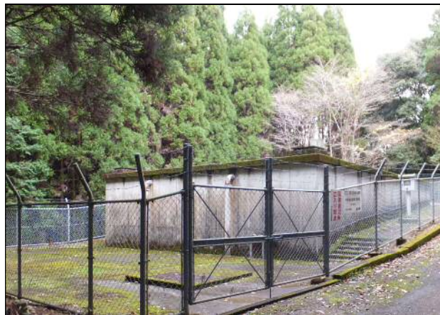
図 3-3. 中央第 1 配水池(平成 7 年度築造)
