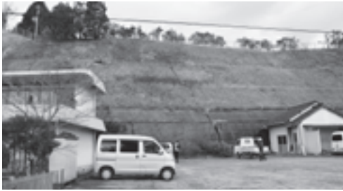
▲大口中央中学校の南側法面
