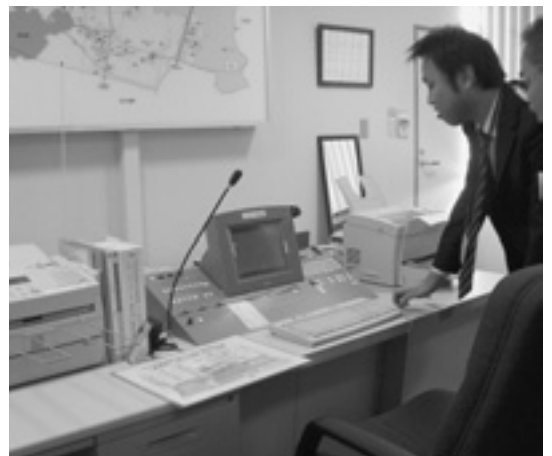
庁舎に完備された防災無線
