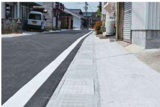
整備された排水路
