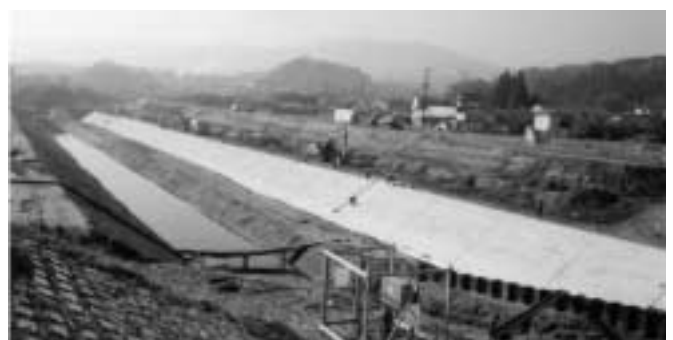
改修がはじまった川間川
