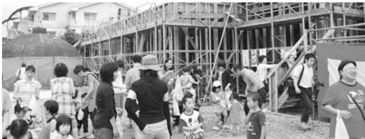
おぎゃー献金記念ホール横に建設中の「子育て交流センター」上棟式当日
