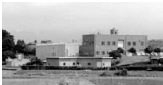
平成29年度まで稼働予定の汚泥再生処理センター
