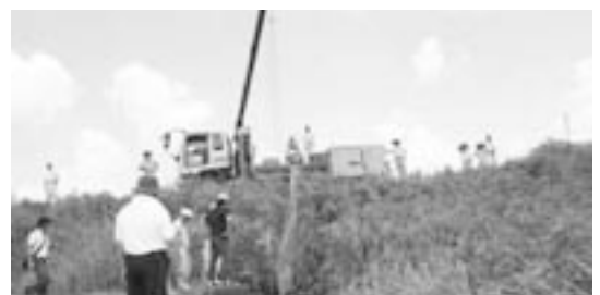
ポンプ設置訓練
