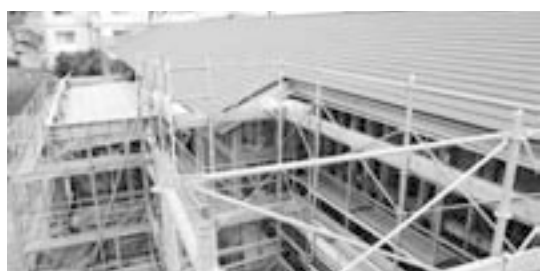
建設中の子ども発達支援センター
