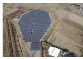
2月1日、大口大田に「ハヤシソーラーシステム高柳発電所」が開所しました。発電所があるのは高柳池跡地で、平成25年度に市がこの遊休地活用について公募を行った結果、㈱林建設が選定されました。発電規模は14,600㎡の敷地に太陽光パネル4,300枚、総出力は1,200kwです。
