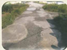
農道の窪みの補修
