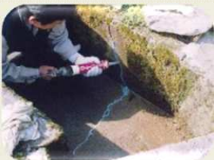
水路のひび割れ補修
