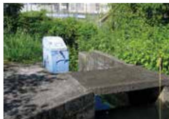
里（中央）水路元町井堰
