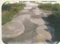
農道の窪みの補修
