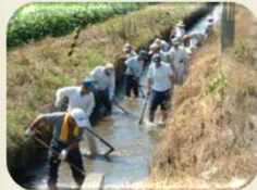
水路の泥上げ
