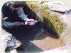
水路のひび割れ補修
