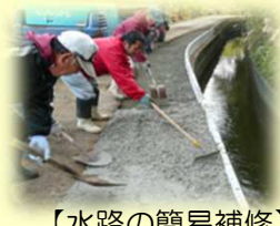
【水路の簡易補修】
