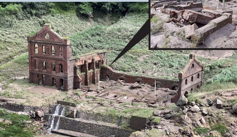
▼曾木発電所遺構の壁面が崩壊
