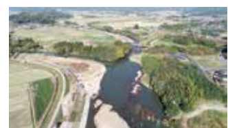
羽月川の河道掘削工事
