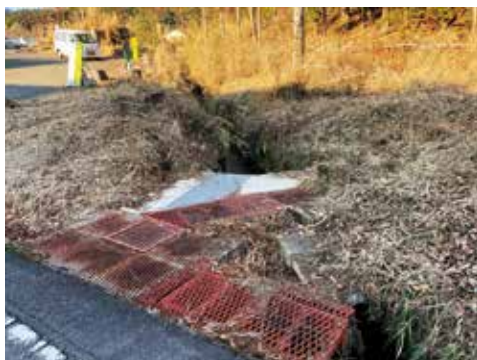
改修予定の水路
