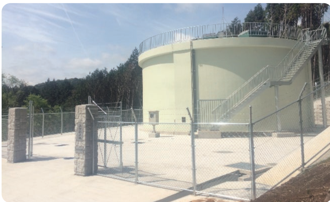
市水道の配水池
