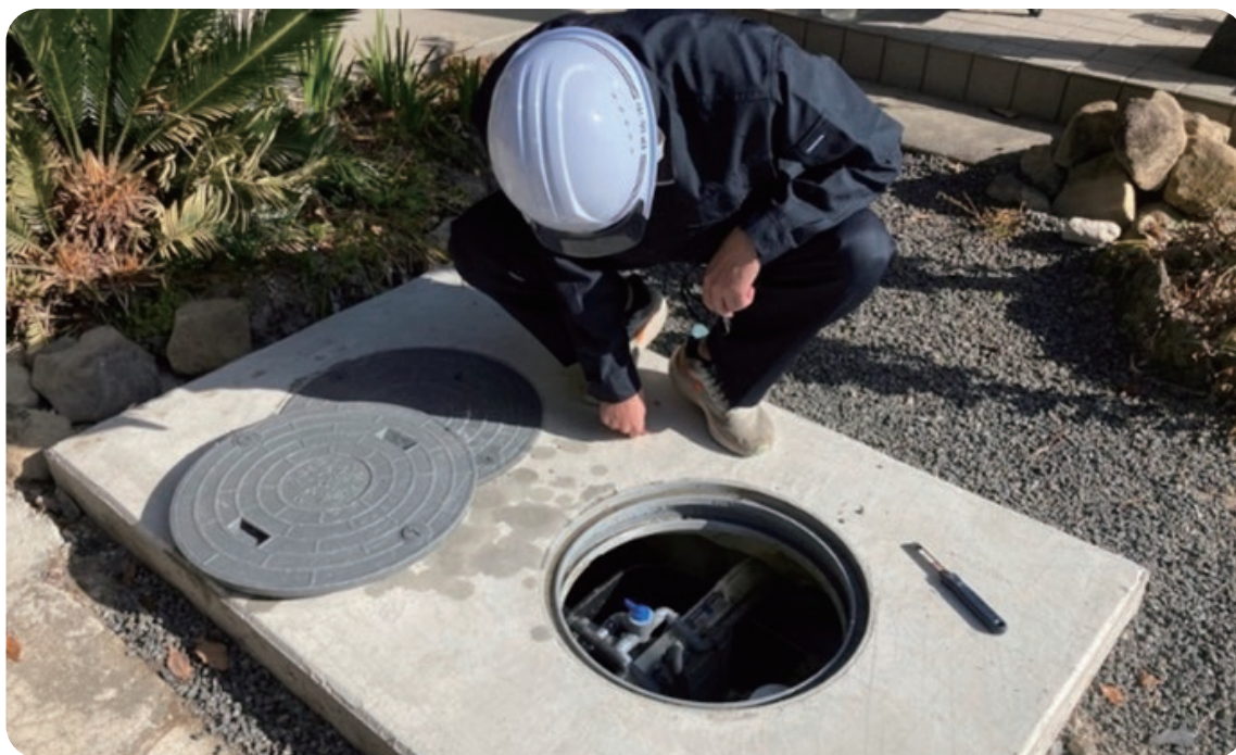
合併処理浄化槽の設置
