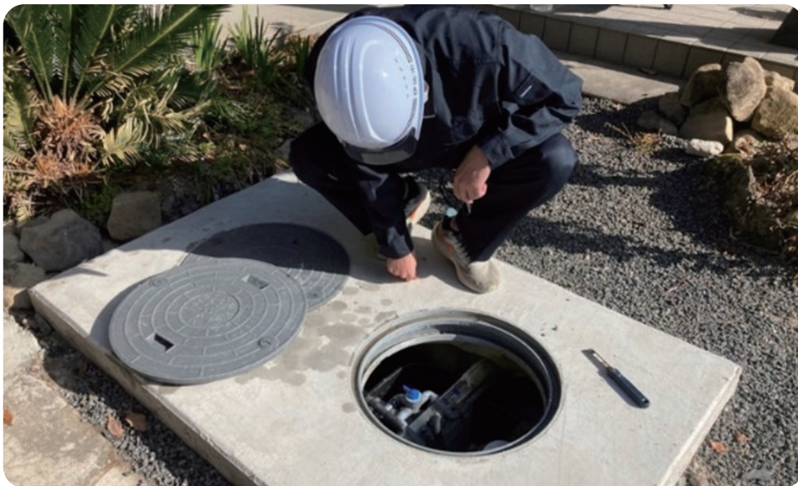
合併処理浄化槽の設置
