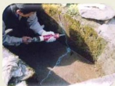
水路のひび割れ補修
