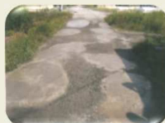
農道の窪みの補修
