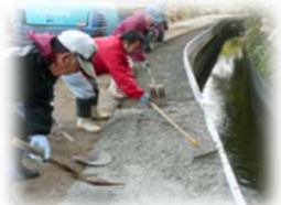
【水路の簡易補修】
