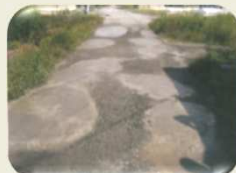
農道の窪みの補修
