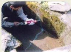
水路のひび割れ補修
