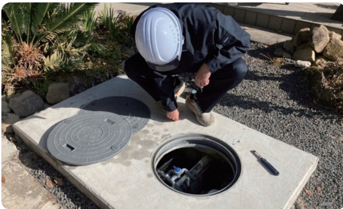
合併処理浄化槽の設置
