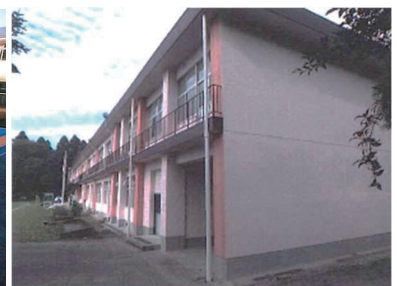
校舎外壁塗装
