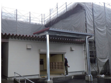
コンテナ室等外壁補修
