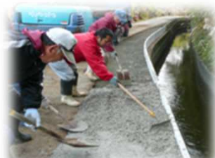
【水路の簡易補修】
