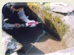
水路のひび割れ補修
