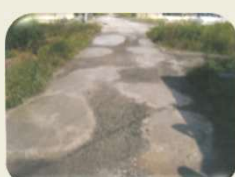
農道の窪みの補修
