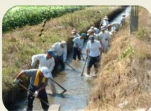
水路の泥上げ
