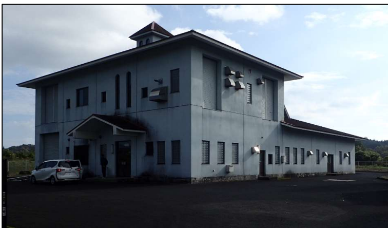
菱刈北部地区処理施設
