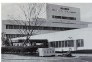
昭和61年4月、現在地に新築移転した県立北薩病院
